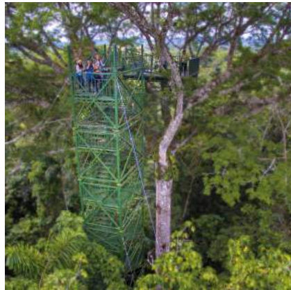
TORRE DE OBSERVACIÓN (38m)
